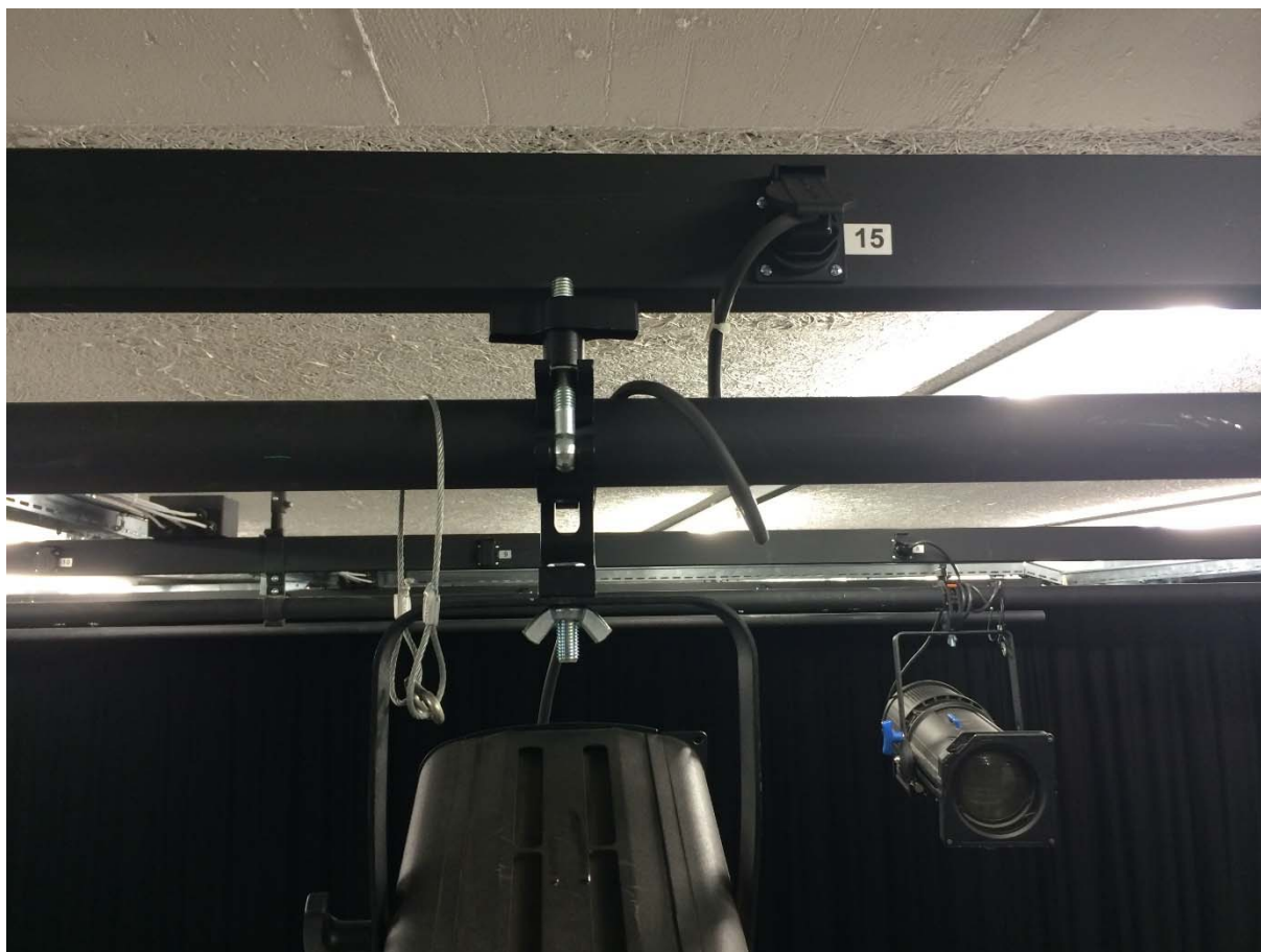
Blick auf Steckleisten an Aufhängevorrichtungen
